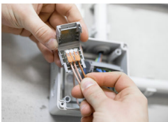
Verdrahtete Klemme in die Gelbox einlegen.
